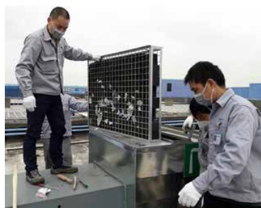
屋外排気装置にカーボンフィルターを設置する様子（中国）
