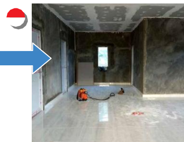
同年10月，施工完成。
