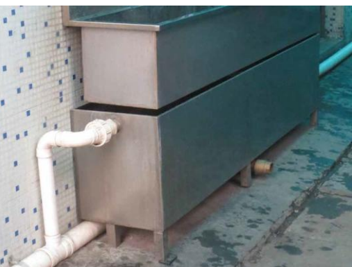
收集洗手池的废水通过水泵输送的装置（中国）
