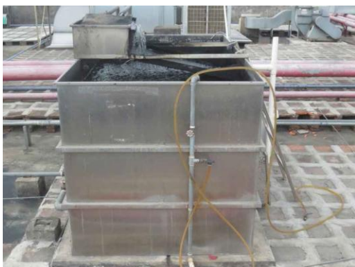
安装在楼顶的废水过滤器（中国）
