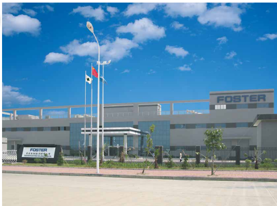
中国工場の外観
