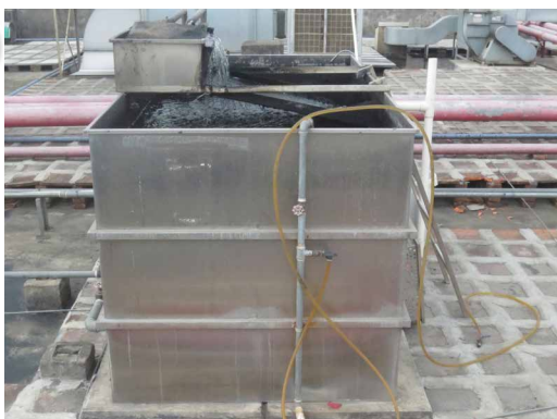
屋上に設置した排水用フィルター（中国）
