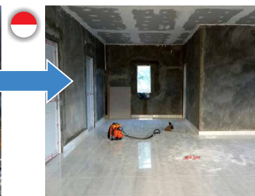
同年10月取付工事完了
