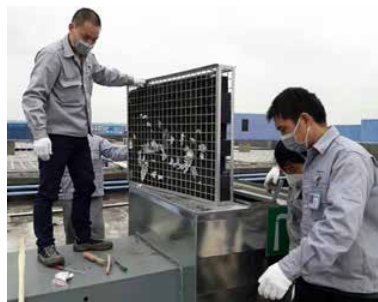
在室外排气装置上安装碳过滤器的情形（中国）
