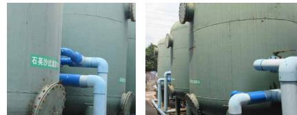
工程で使用する水の再利用
