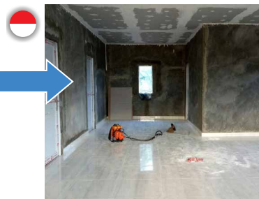
同年10月取付工事完了
