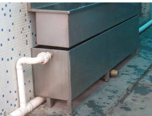
洗面所の排水を集めてポンプで送る装置（中国）
